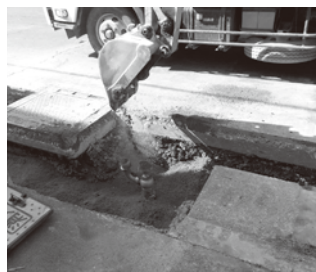
▲砂で埋め、舗装して仮設配水管の設置工事完了
