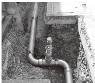
▲地下式消火栓も仮設で 設置
