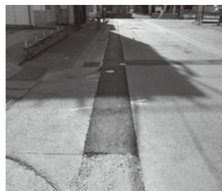
▲砂で埋め、舗装して仮設配水管の設置工事完了
