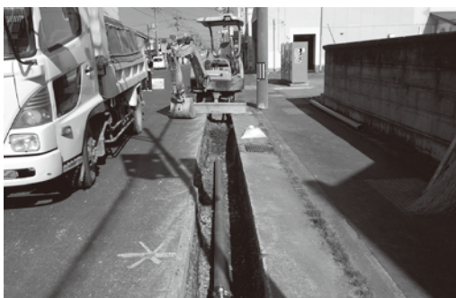
▲道路を掘って仮設配水管を設置
