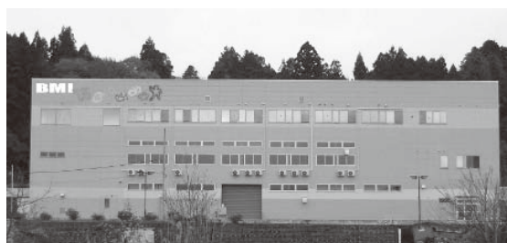
当社 坂下事業所マテリアルリサイクル(中間処理)施設
