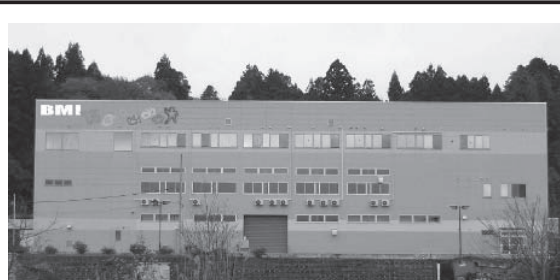
当社 坂下事業所マテリアルリサイクル(中間処理)施設
