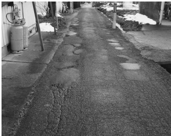
要望の多い道路改修
