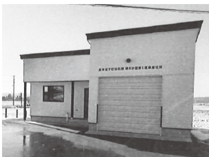
整備された御池田車庫屯所
