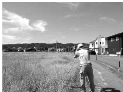
旧坂下厚生病院跡地測量の様子
