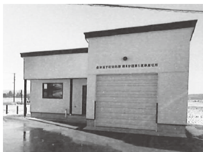
整備された御池田車庫屯所
