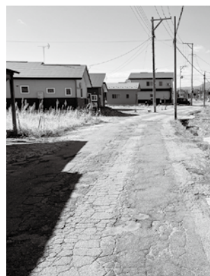
都市計画道路坂下喜多方線 (原街道)
