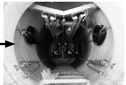
マンホール形式ポンプ場 設置完了
