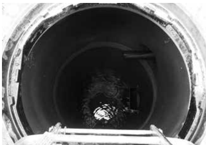
ポンプ設置前の状況
