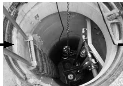
ポンプをガイドパイプに沿って設置
