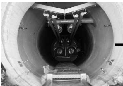
ポンプ設置するためのガイドパイプ等の設置
